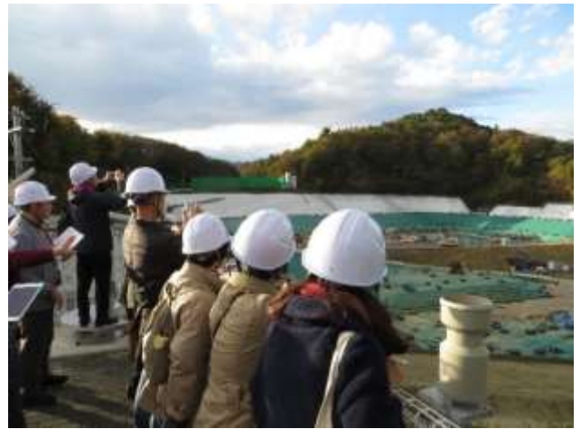
特定廃棄物埋立処分場
