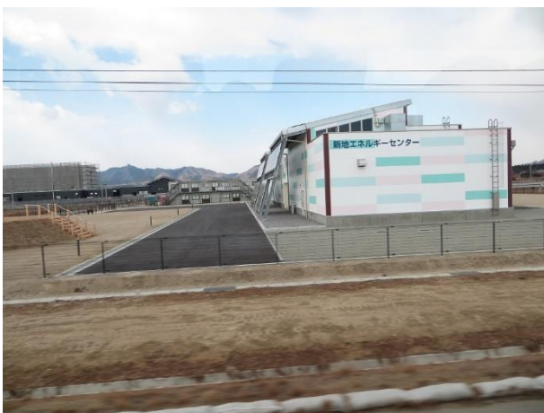
エネルギーセンター
