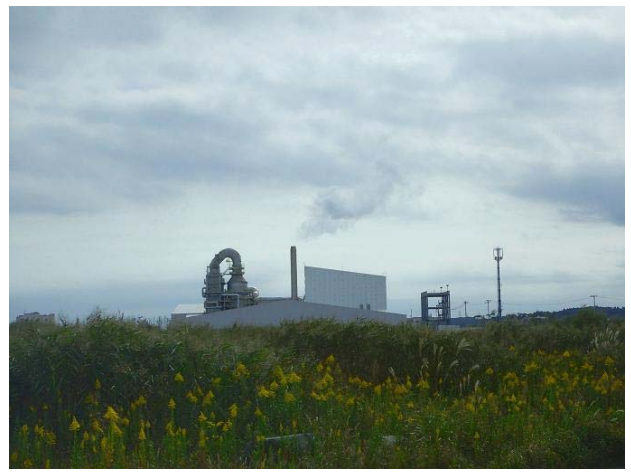
浪江町仮設焼却炉
