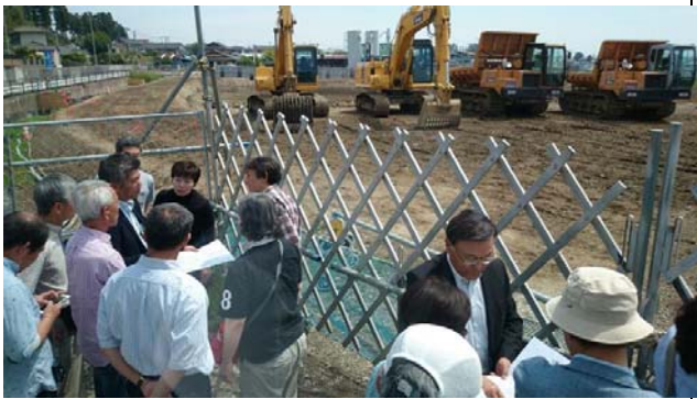
22 いわき市の勿来酒井地区にある復興公営住宅の建設予定地現場、お話し。
