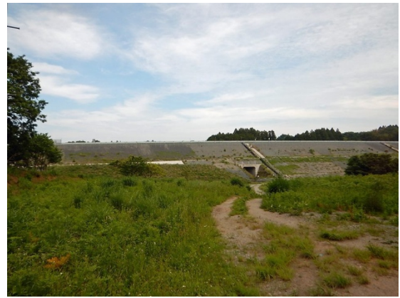
08 常磐道のインターチェンジを新たに双葉町、大熊町に建設する計画があります。その双葉インターチェンジの予定地です。ここと、町の復興拠点を結ぶ幹線道路も整備される計画です。
