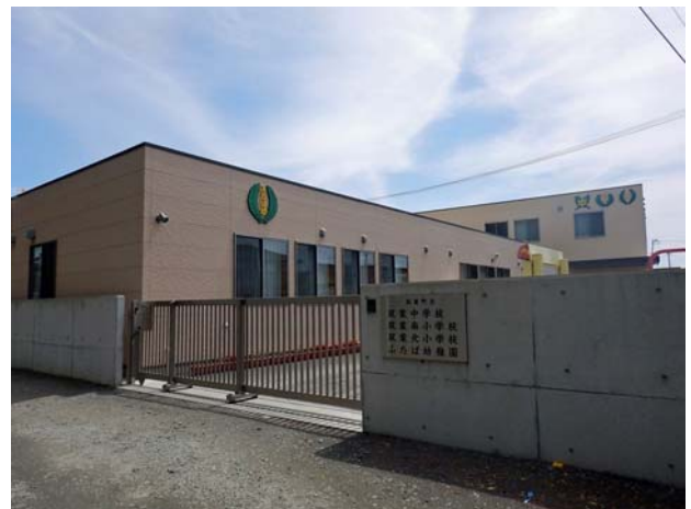
18 双葉中学校、双葉南小学校、双葉北小学校、ふたば幼稚園が1か所に集まっている仮設校舎。生徒数は全部で35名。少人数であることを逆に活かし、ICT教育も取り入れているそうです。グラウンドがないことが課題。
