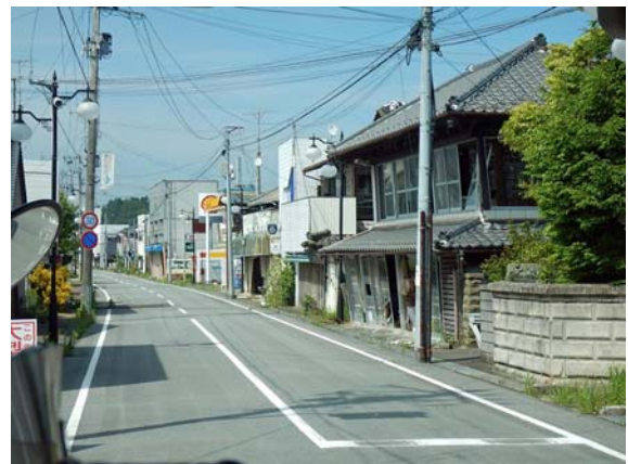
10 双葉駅に近いメインストリート。倒壊して道路をふさいでいた建物は撤去されていますが、ほとんどの建物は手つかずのまま。
