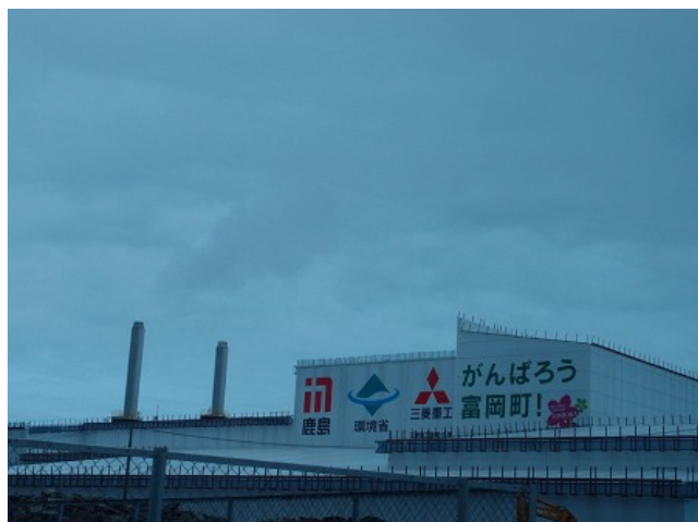
毛萱 (稼働した焼却施設)
